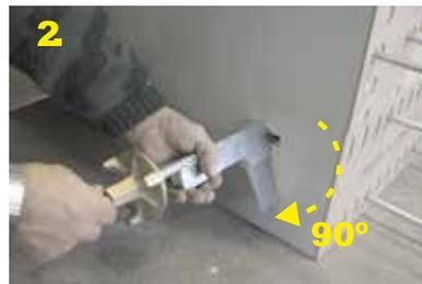
2 Selbstsicherung der UNI-Ka Auflagekonsole durch Drehung um 90°.
