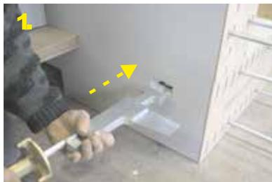
1 Einführen der UNI-Ka Auflagekonsole in die UNI-Ka Aussparung.
