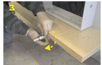
3 Verspannung des Gerüstbrettes (Diele) oder der Schalung direkt gegen die Bodenplattenstirne.
